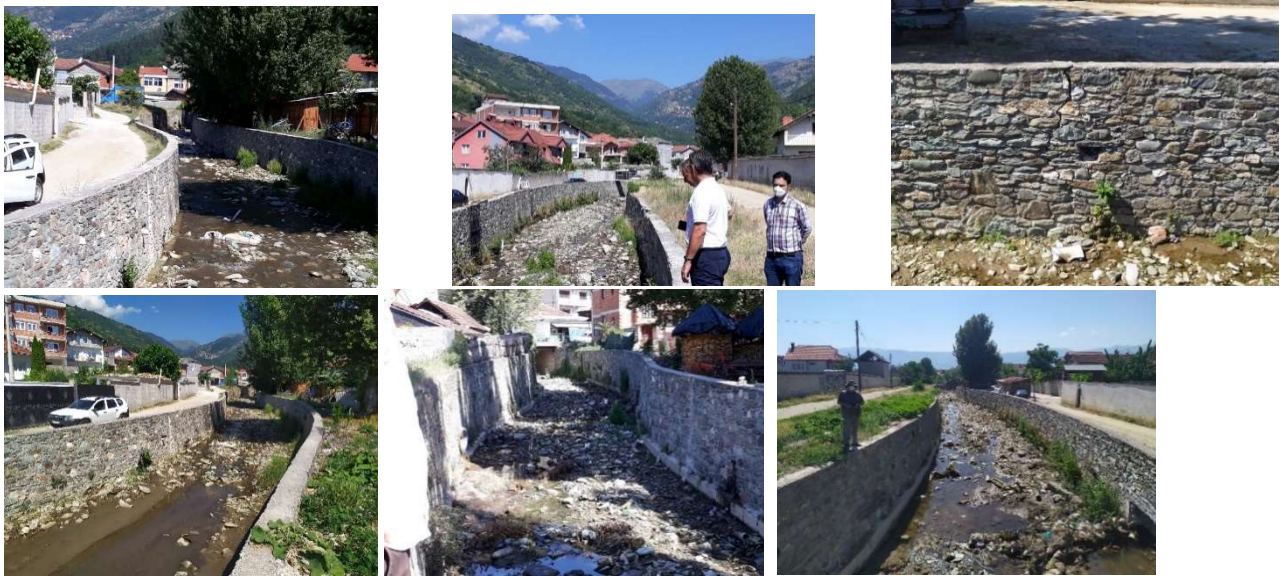
Слика 52 - Карактеристични вертикални сидови од камен во цементен малтер .
