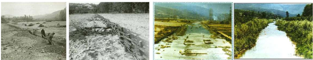
Слика 28 –Уредување на р. Перперек (Бугарија) со бионинженерски метод
