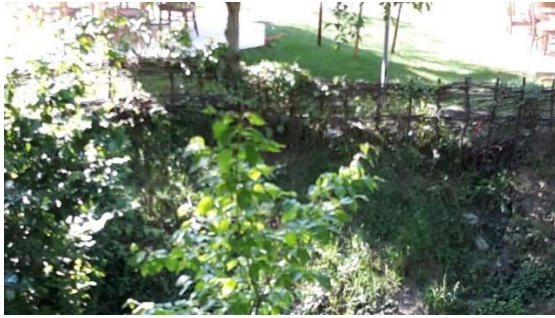
Слика 48 - Ограда на ресторанот од плетери кои служат и за зацврстување на косините на брргот
