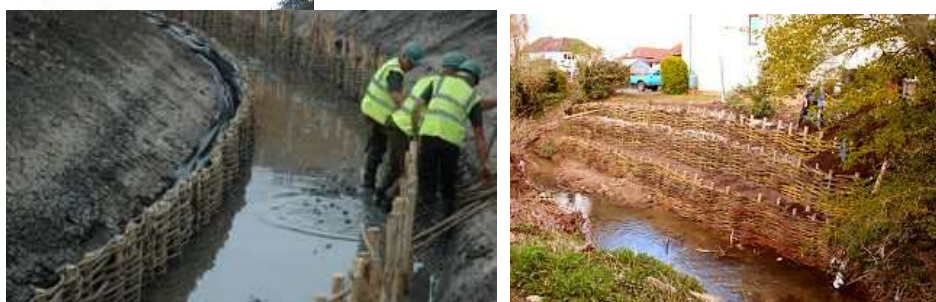
Слика 32 - Обезбедување на бреговиет со живи плетери
