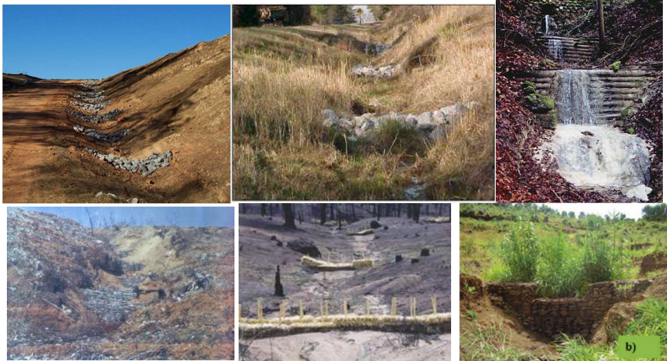
Слика 27 - Прагови од разни материјали - камен во суво, камен во цементен малтер, трупци, плетери, вреќи со песок ил сламени бали, габиони .....
