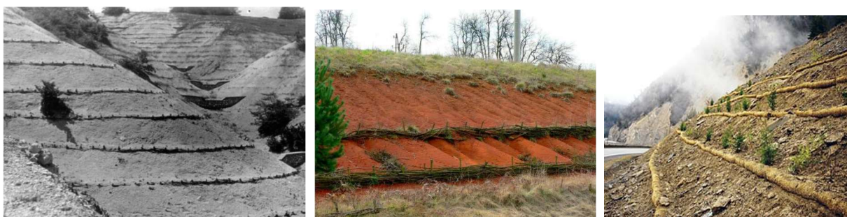
Слика 20 Изградба на попречни сидови од плетери, фашины и вреки (со песок ил слама)
