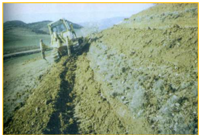
Слика 3. Подготвени контурни бразди за садење/пошумување со примена на механизација
