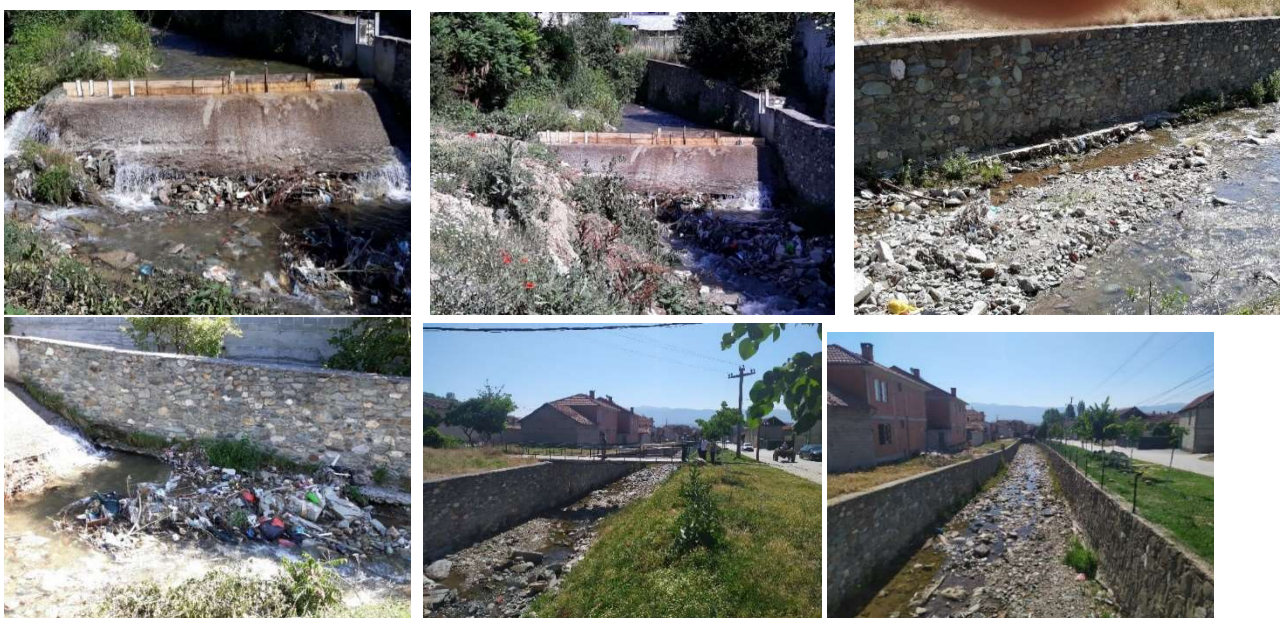
Слика 53 - Регулација околу зафатот во селото и низводно
