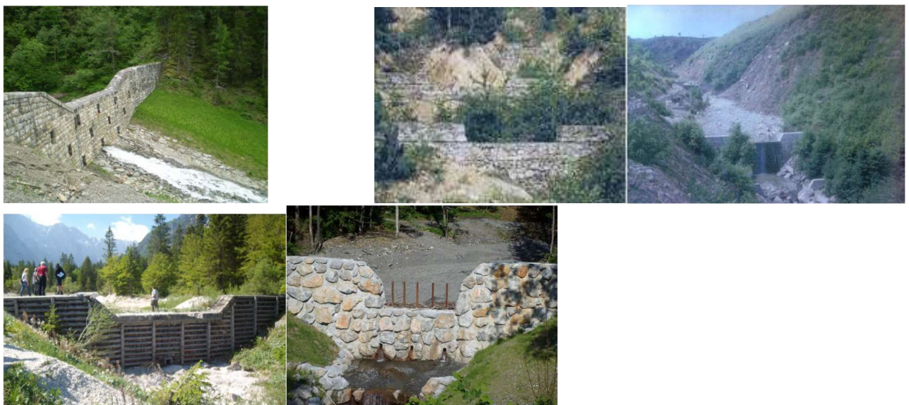
Слика 22 – Затворен тип на прегради од разни материјали (камен во цементен малтер, габиони, бетон, комбинирано бетон и камен) - (примери од Словенија, Австрија, Бугарија)
